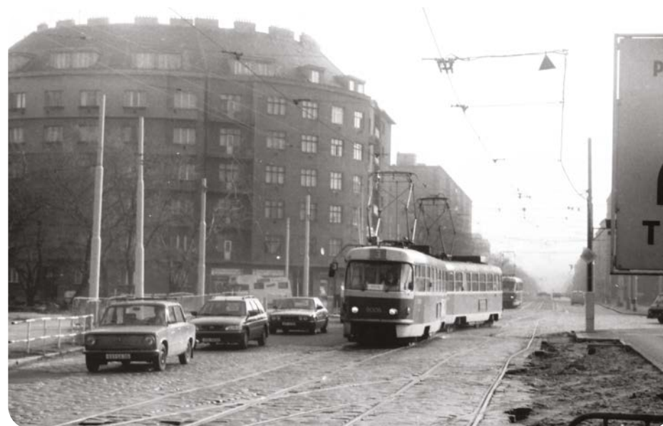
Snímek z 21. dubna 1994 dokumentuje stavební práce na Balabence. Z původní odbočky do Českomoravské ulice už zůstaly jen neodtěžené výhybky ve vozovce a nové rozvětvení tratí je posunuto přibližně o 30 metrů východním směrem. Původní kolejová i silniční křižovatka musela být posunuta, aby uvolnila místo budoucímu silničnímu přemostění. Na lince 3 je vypravena souprava tramvají T3M s tyristorovou pulzní regulací.
