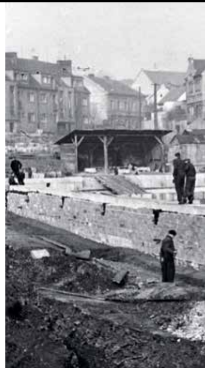
▲ Výstavba koupaliště začala v roce 1953 v místě bývalého rybníku
