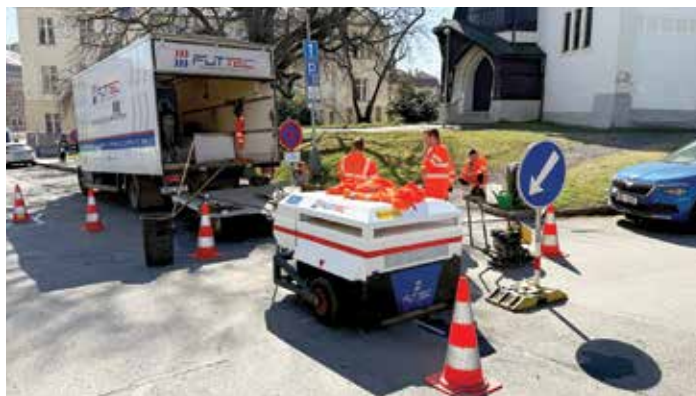
▲ Revoluční oprava vozovky mikrovlnnou technologií
