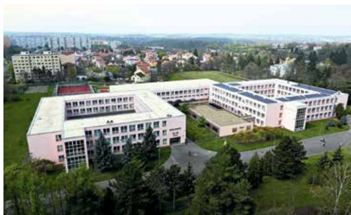
▲ Stavba objektu by měla trvat rok
