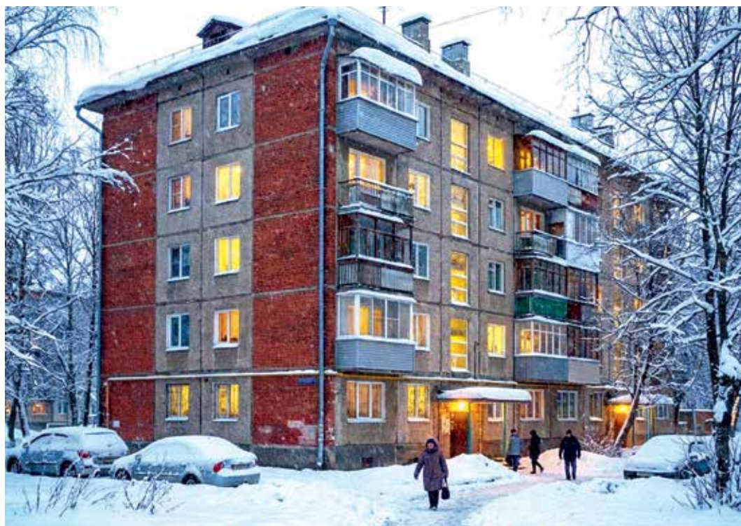
▲ Tepelné čerpadlo do rodinného nízkoemisního domu s topením v podlaze je dobrá věc. Ale tepelné čerpadlo do panelového nebo bytového domu je poměrně velká komplikace
