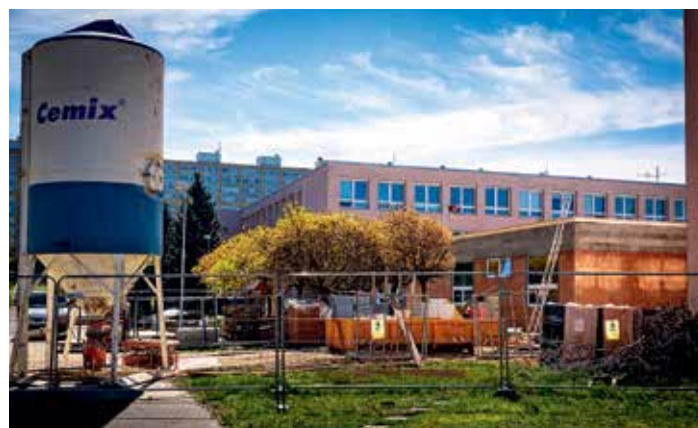
▲ Stavba přístavby družiny v ZŠ Ústavní
