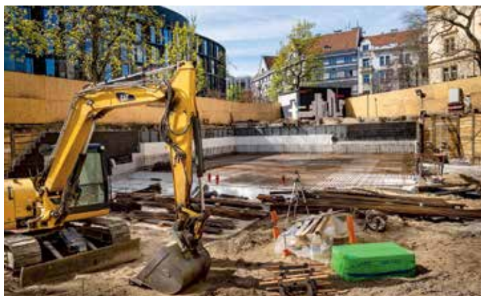
▲ Příprava přístavby pravého křídla historické budovy ZŠ Lyčkovo náměstí s tělocvičnou
