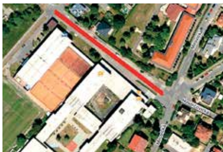
▲ Část Hovorčovické ulice čeká nový dopravní režim
